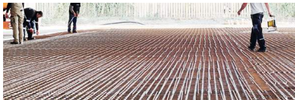
Vor der Fertigstellung gab es für die Bauarbeiter einiges zu tun.
